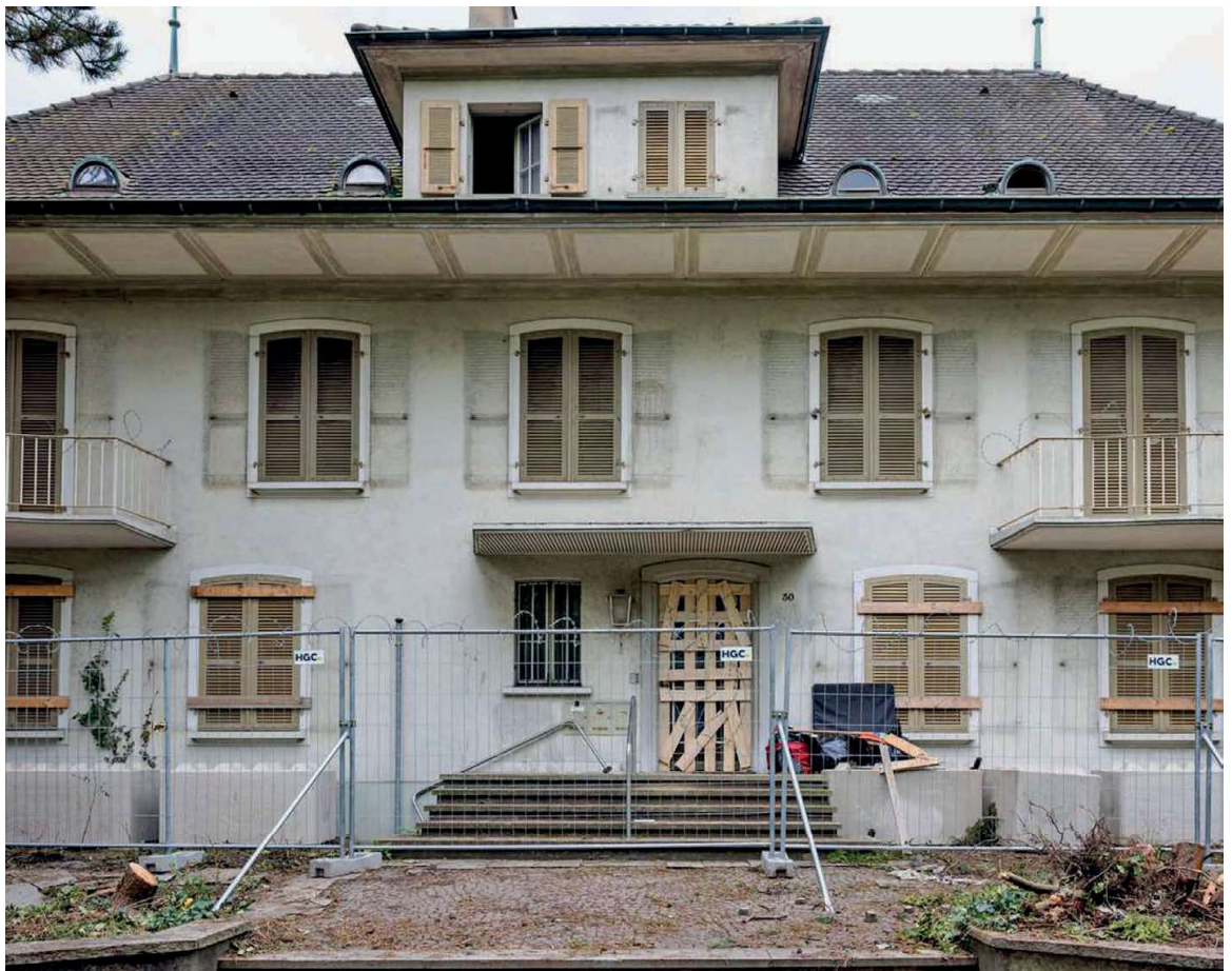
Le Canton de Berne a prévu d'installer jusqu'à 66 personnes dans la «villa du directeur» de l'ancienne aire Bühler.
